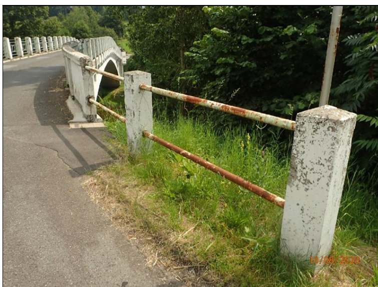
Jednoduché zábradlí navazující na L parapetní zeď za O2.
