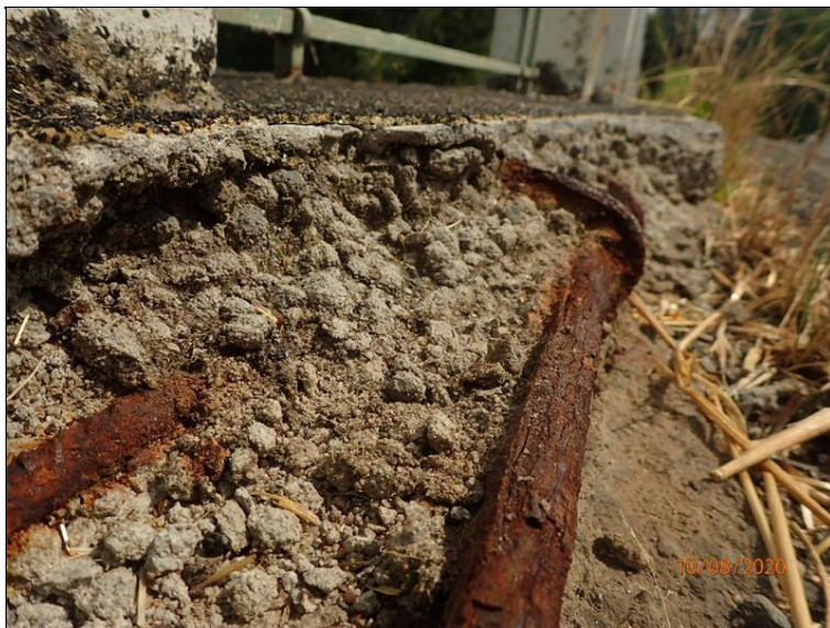
Detail z výše uvedené foto, P odrazná obruba.
