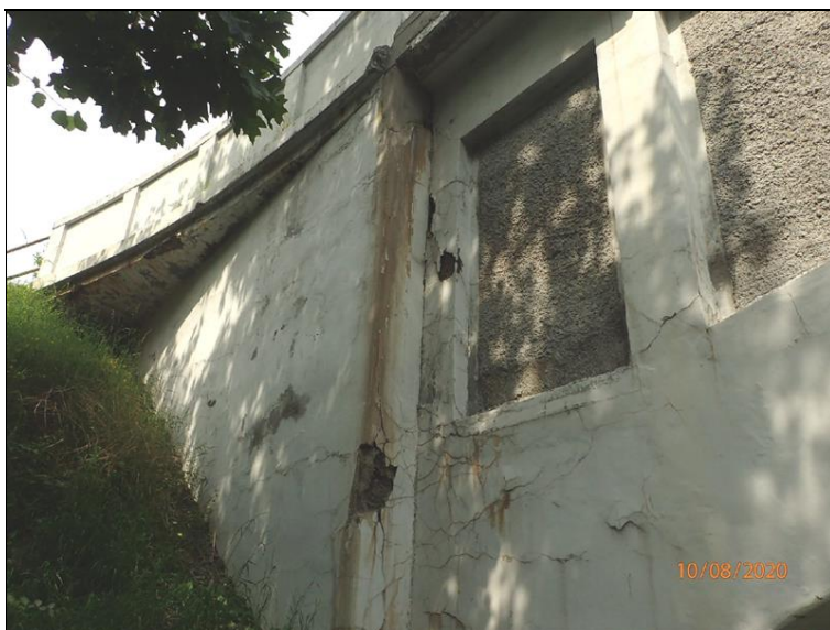
L bok O2, konec čelní zdi, líc křídla s vrcholovou konzolou.
