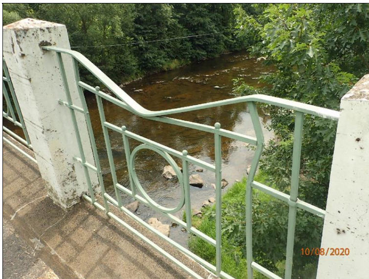
Poškození výplně L zábradlí.
