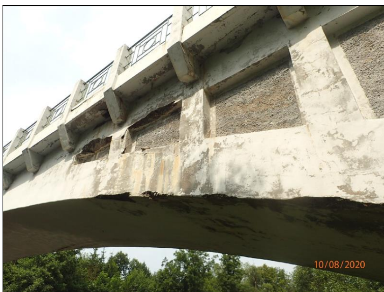
L bok mostu, čelní zeď v úseku před O1.
