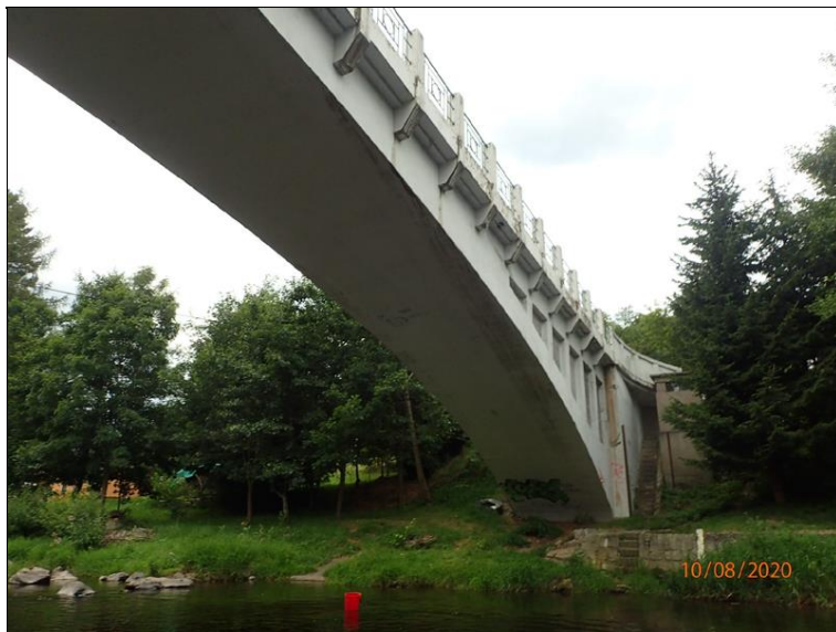
P bok + podhled mostu, úsek u O2.
