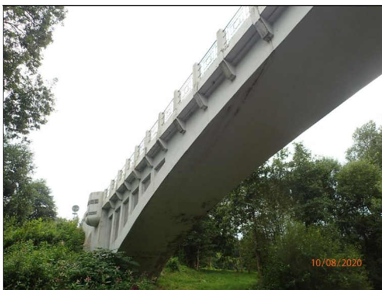
P bok + podhled mostu, úsek u O1.
