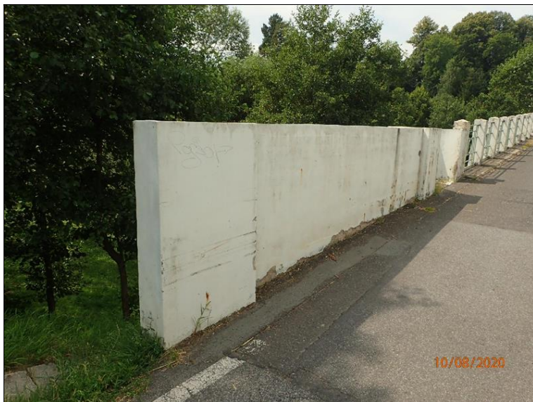
L zábradelní parapetní zeď nad O1.
