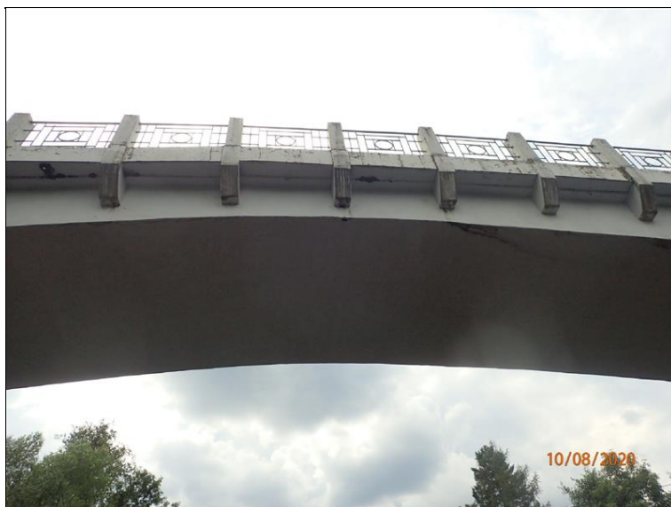
P bok + podhled mostu, vrcholový úsek klenby.
