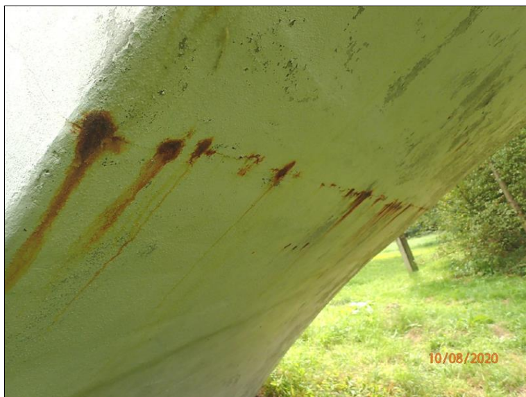
Podhled klenebního pásu, v místě původního kloubu před O1.
