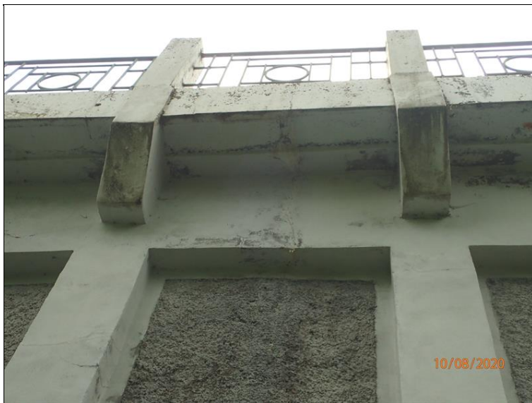
P bok, úsek před O1, pohled konzoly čelní zdi.
