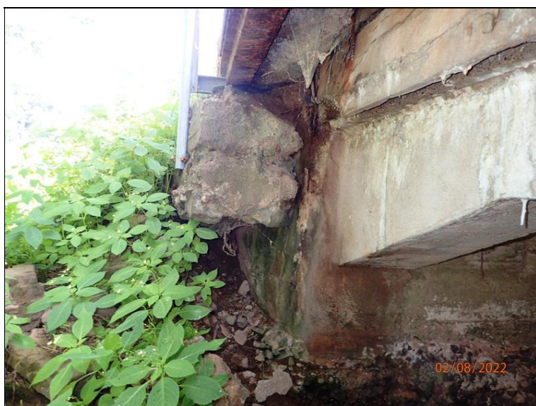
P bok opěry O1, vodou podemletý úložným blok "visí na" ocelovém nosníku, který měl podporovat
