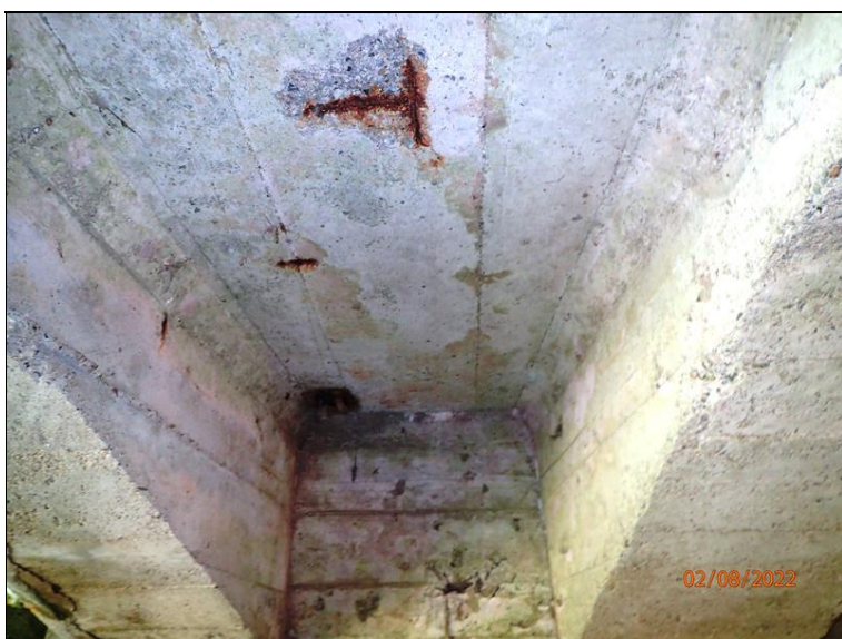
Podhled mostovky mezi trámy 1P - 2P před lícem O1.
