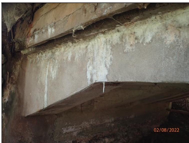
Bok krajního trámu 1P, úsek před O1.
