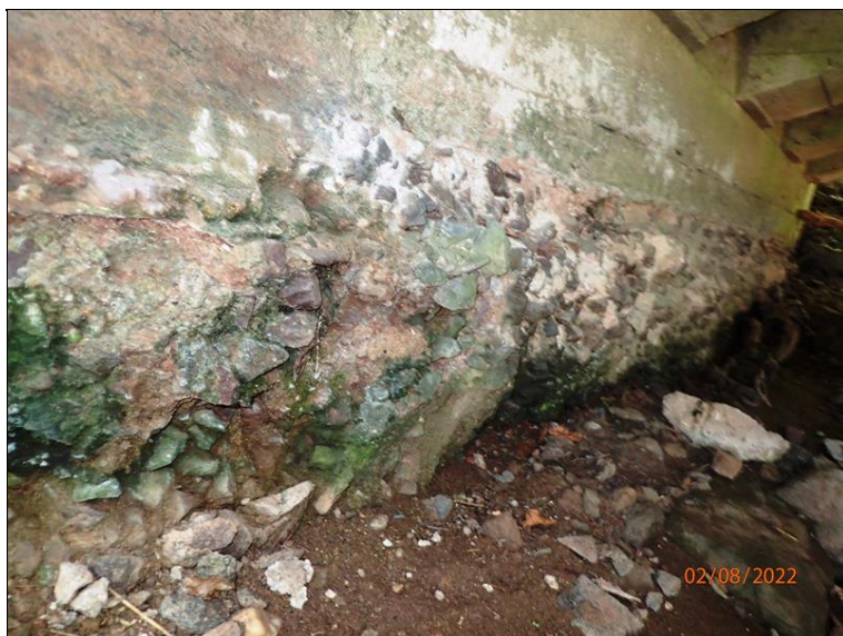
Opěra O1, detail líce v pásu nad dnem vodoteče.
