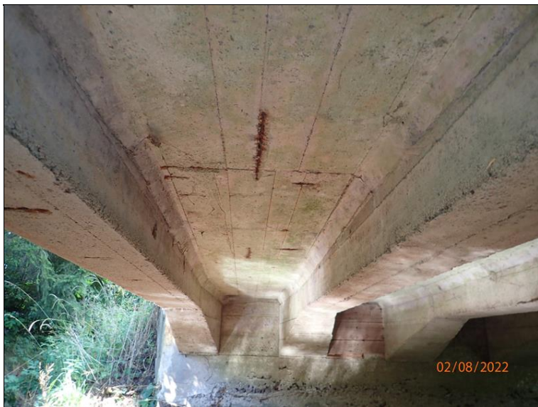
Podhled NK u L boku mostu, směrem k O2.
