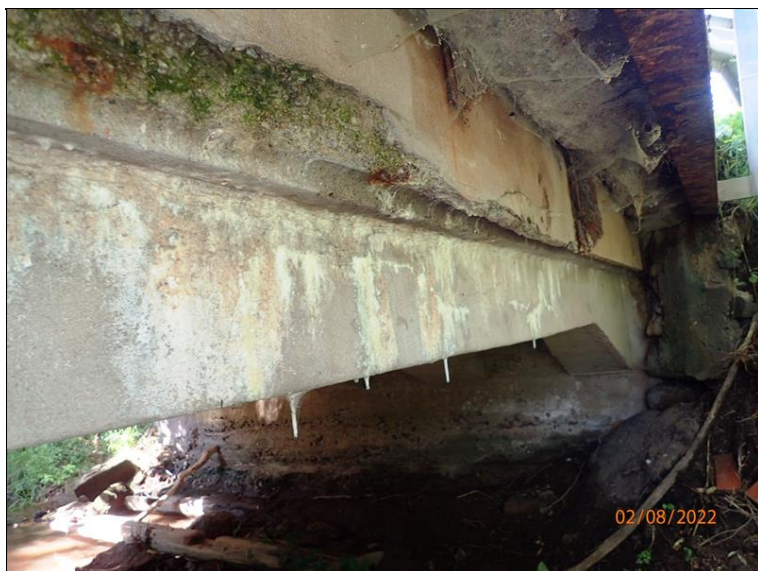
P bok mostu s rozšířenou ocelovým nosníkem podporovanou římsou, pohled směrem k O2.
