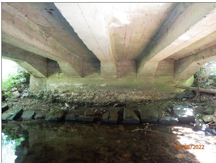
Podhled NK, vnitřní úsek, směrem k O1.
