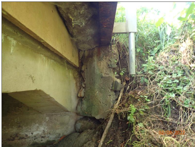
P bok opěry O2, úložný blok ocelového nosníku.
