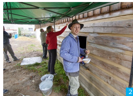
2 | Vápnění roubenky. Rekonstrukci si členové spolku částečně provádějí sami. Foto: Petr Pivoňka.
