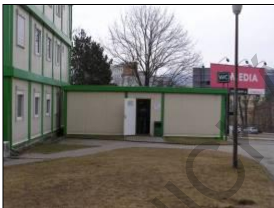
foto 6 areál autobusového nádraží v Liberci zázemí (na pozemcích druhého souboru – LV č. 1) objekt sociálního zázemí (jednopodlažní stavba uprostřed)
