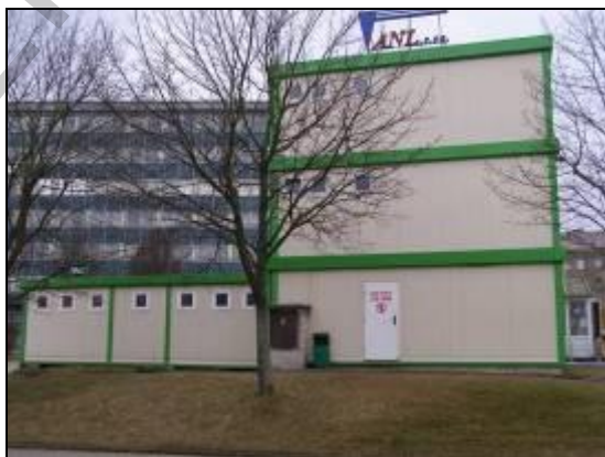
foto 8 areál autobusového nádraží v Liberci zázemí (na pozemcích druhého souboru – LV č. 1) administrativně – provozní objekt (vpravo) a objekt sociálního zázemí (vlevo)
