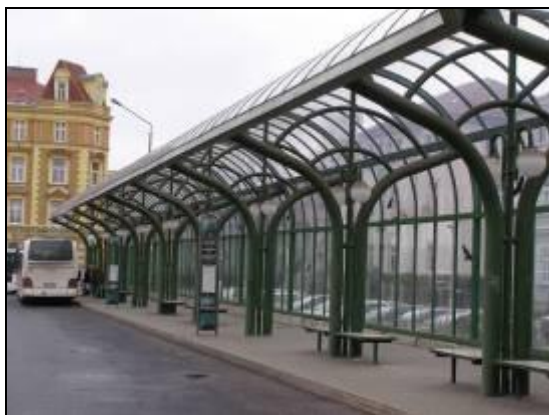
foto 1 areál autobusového nádraží v Liberci terminál (na pozemcích prvního souboru – LV č. 1603) kryté stání (1)
