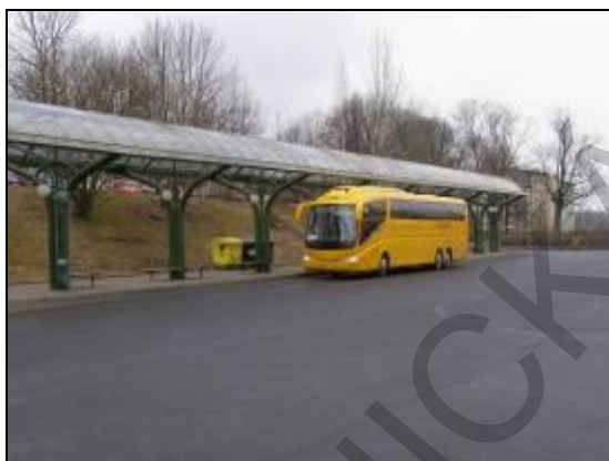
foto 2 areál autobusového nádraží v Liberci terminál (na pozemcích prvního souboru – LV č. 1603) komunikace
